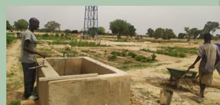
Travaux de réalisations des bassins d'eau dans les PM de Bogossoni/San/CNOP/ Juin23
